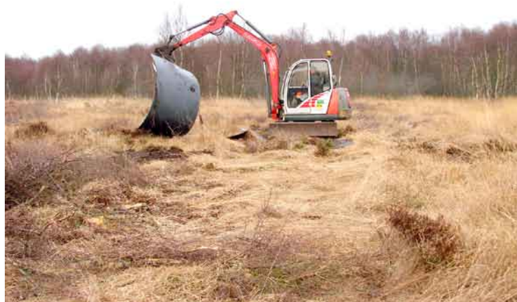
Figur 22. Mindre gravemaskine på køreplader af plastmaterialer.
