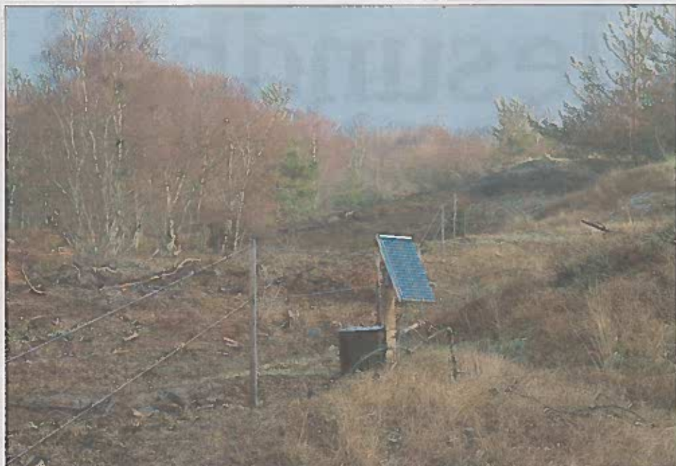
Nord for Foldgårdsøen er opsat hegn, som får strøm fra solpaneler og batterier.
