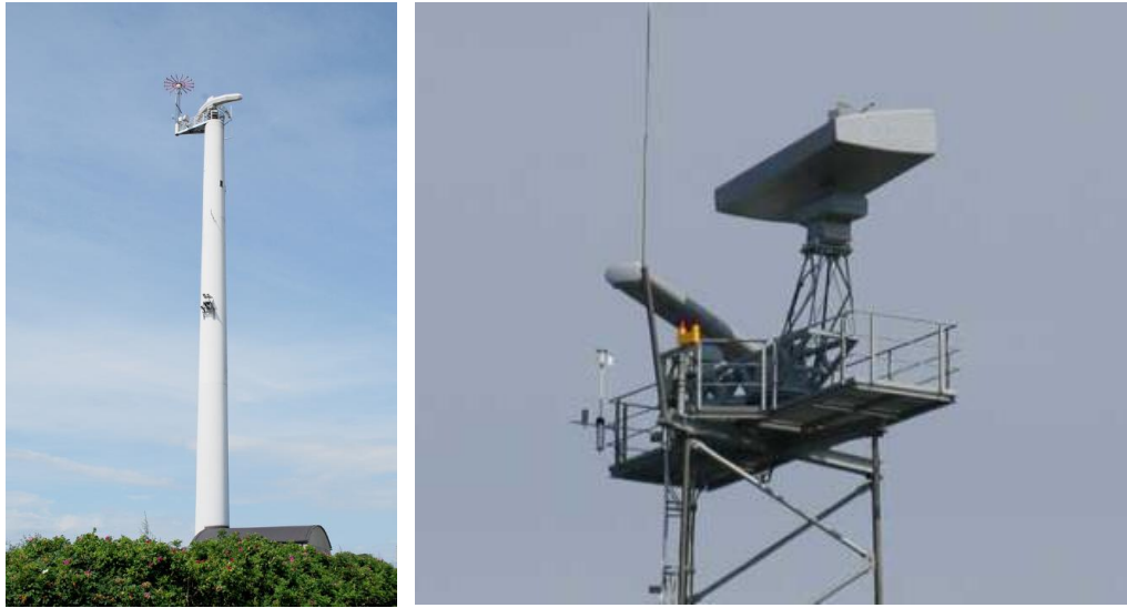
Figur 4-4 Til venstre ses Scanter 2000 radaren der er opstillet i Hou. Til højre ses den ene af de store Scanter 4000 radarer, der er opstillet i Keldsnor./11//12/
