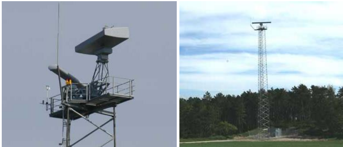
Figur 4-4 Til venstre ses den ene af de store Scanter 4000 radarer, der er opstillet på Sjællands Odde. Til højre ses Scanter 2001 radaren, der er opstillet på Røsnæs. /11//12/
