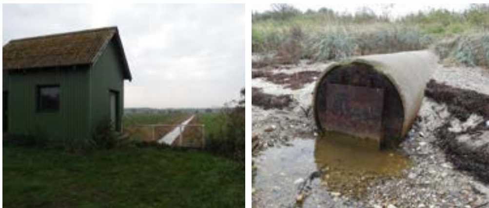
Figur 2.7.3: Pumpestation samt udløb med påmonteret kontraktap med bundkote 0 m DVR 90.
