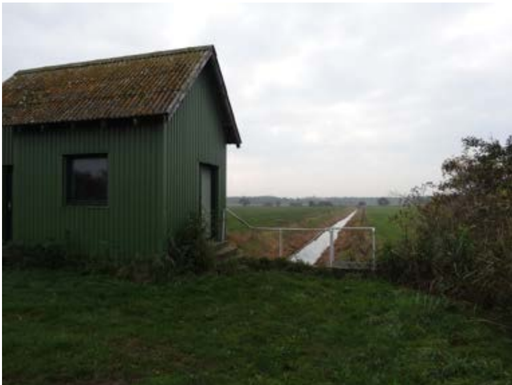
Foto: Pumpestation med to Lykkegaard Pumper i pumpehuset. Bagved ses afvandingskanalen C, som samler vandet fra Landvindingslagets arealer til pumpestationen.
