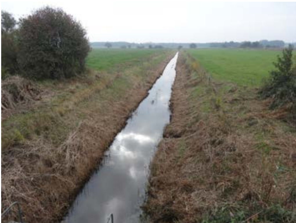
Foto: Afvandingskanal til pumpestationen i det nordøstlige del af projektområdet.
