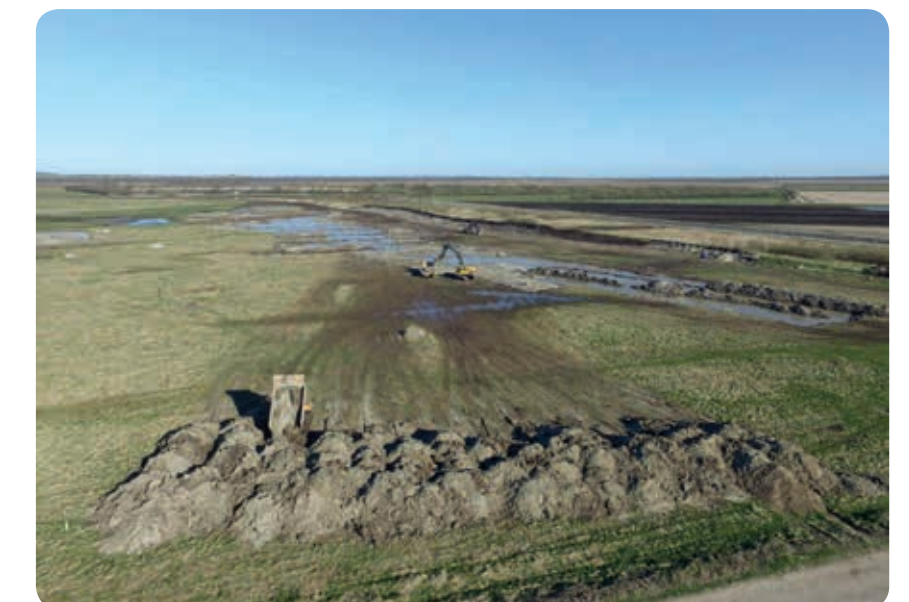
Anlægsarbejder på Birkeseø 2016.
