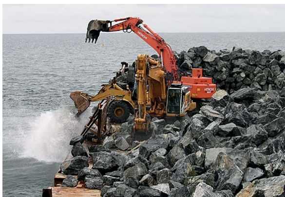
Udlægning af norske sprængsten på Læsø trindel. Placement of quarry rocks on Læsø Trindel.
