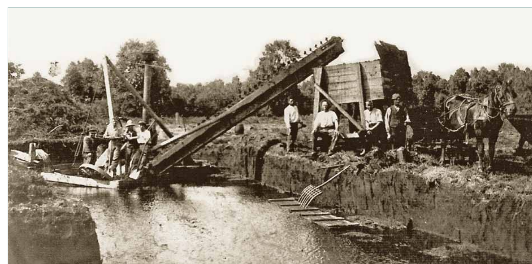
I år 1900 anskaffede Holmegaard Glasværk en æltemaskine. Lokomobil og ælteværk stod på en slags tømmerflåde, der flød på tørvegravens vand. Det æltede tørvpladder blev løftet op i et trug med en slags kopelevator, og herfra kørt ud på læggepladsen i særlige tipvogne. Foto fra ukendt år.
