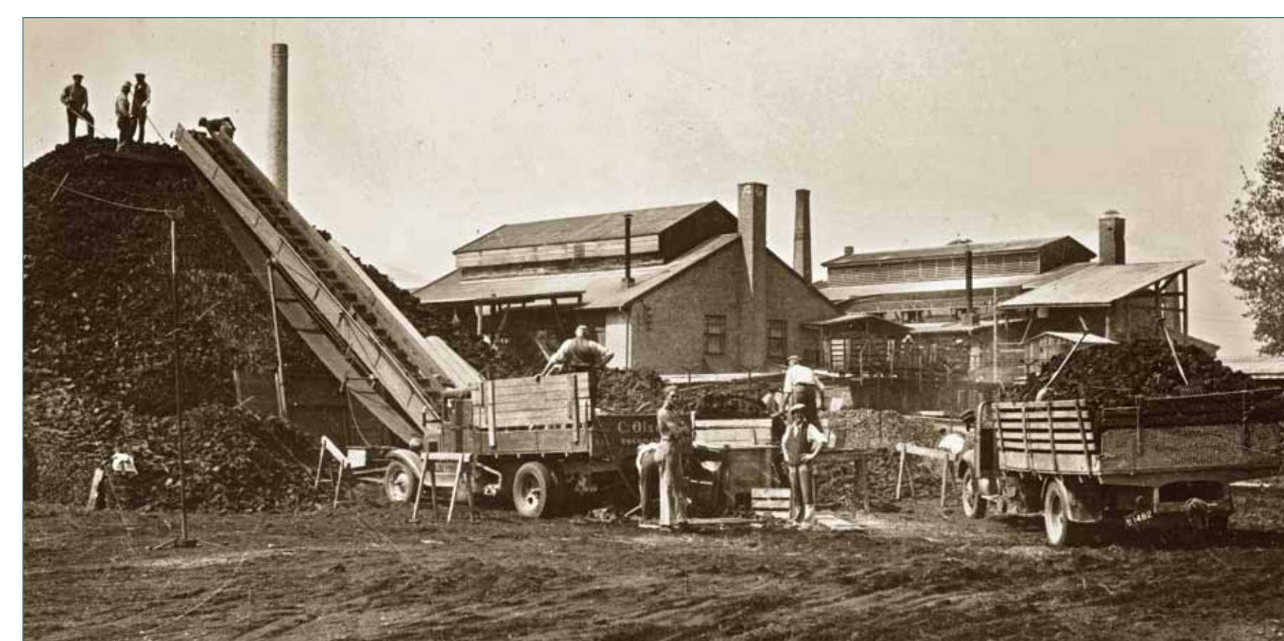
Under Anden Verdenskrig var der brug for rigtig mange tørv på glasværket. Nu talte man ikke længere i millioner styk, men i tons. I visse år blev der gravet 30.000 tons tørv. Det var nu umuligt at oplagre de mange tørv under tag, så de blev stablet op i stakke så store som huse, der lå rundt omkring på glasværkets grund.
