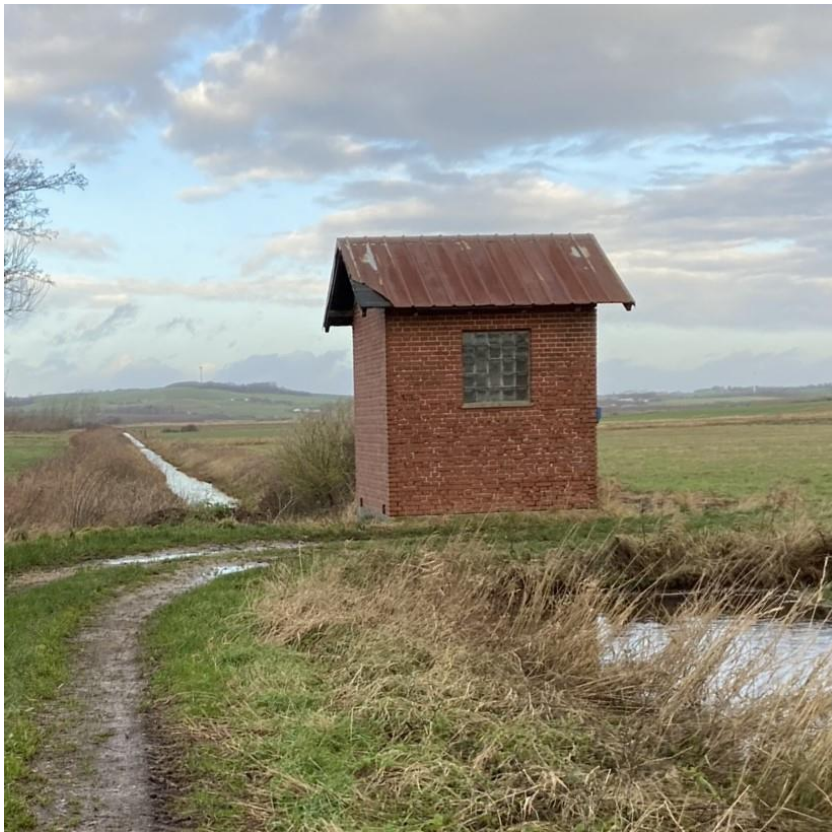
Figur 3.20: Billede af pumpehuset, som er placeret i projektområdet.
