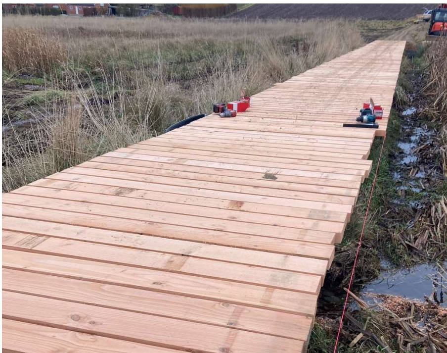
Figur 4.8 Eksempel på boardwalk under etablering ifm. et klima-lavbundsprojekt.
