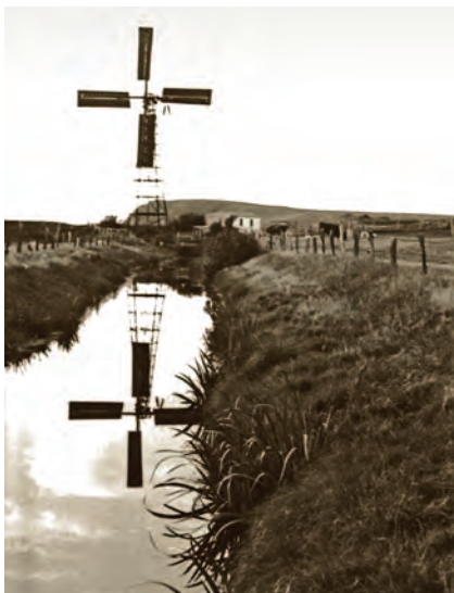
Vindmotor og pumpehus. Foto fra 1950'erne, venligst udlånt af Helnæs Lokalhistoriske Arkiv.
