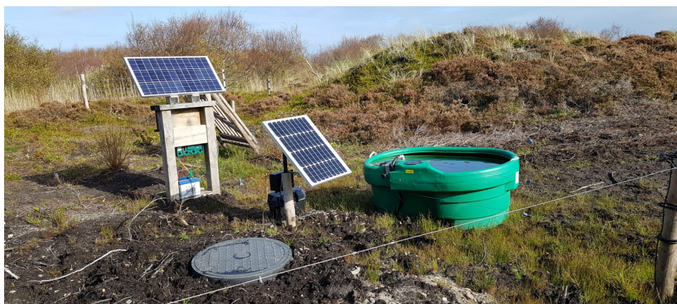
Figur 6-1 Foto af nyetableret kreaturvanding og strøm i hegningen syd for Batteribakke.
