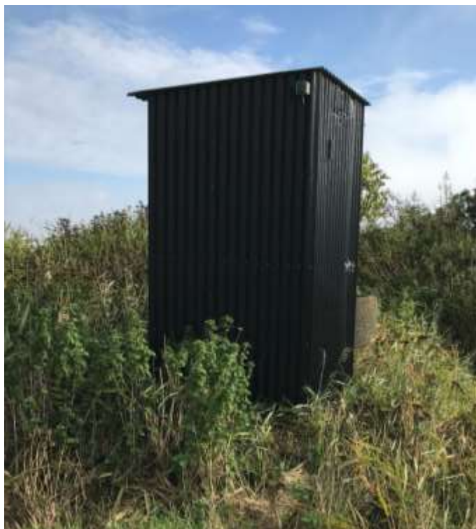
Figur 2.11.3.2 Pumpehuset ved det sydlige undersøgelsesområde, placeret i det offentlige pumpelag Møgelsig.
