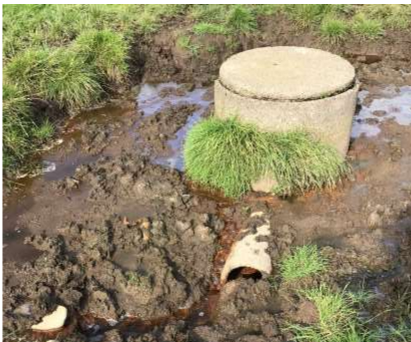
Figur 2.11.1b Foto af en af de synlige drænbrønde i projektområdet.
