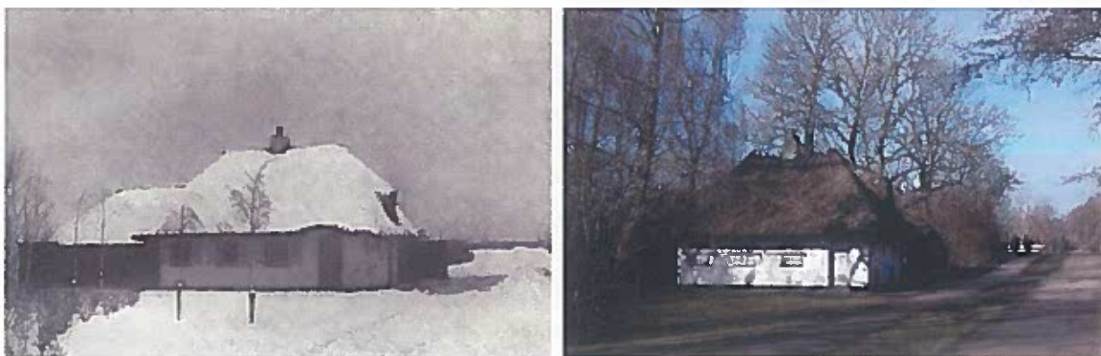
Figur 15. Materielbygningen i Utterslev Moses nordøstlige hjørne taget i henholdsvis 1947 (tv.) og 2018 (th.). Det er tydeligt at se tilgroningen af de tidligere lysåbne arealer omkring bygningen.
