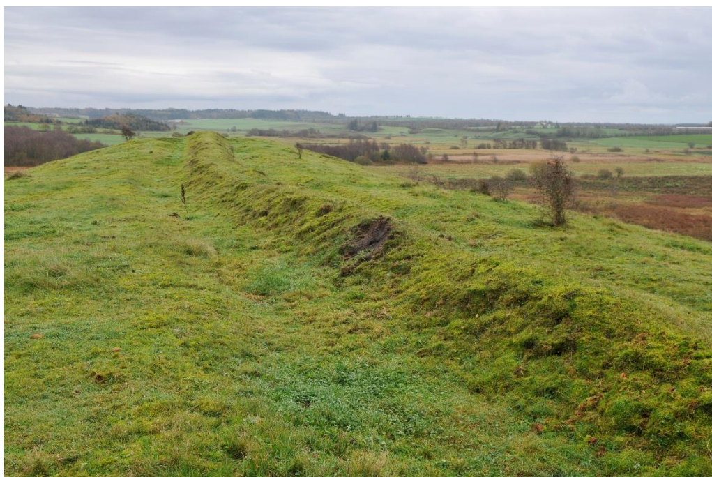
Figur 2.10.4. Foto af beskyttet sten og jorddige i undersøgelsesområdet.
