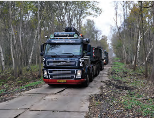
Udkørsel af flis på en pontonbro af 1500 jernplader. MBC Wood chips transported along a "pontoon bridge" made from 1,500 iron plates. MBC
