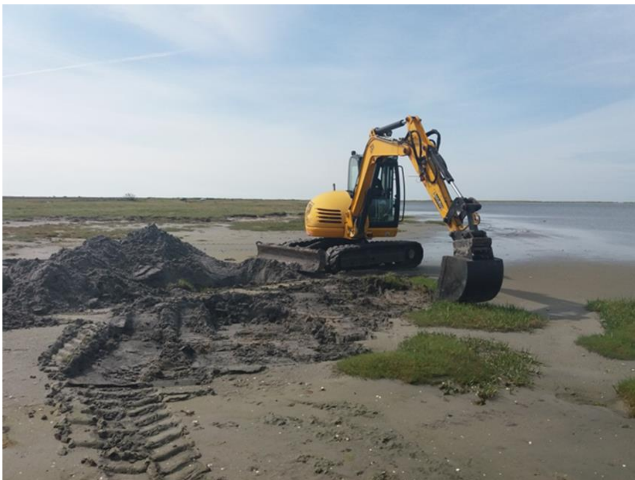
Hullet med vadegræs er under genopfyldning (Foto Naturstyrelsen).
