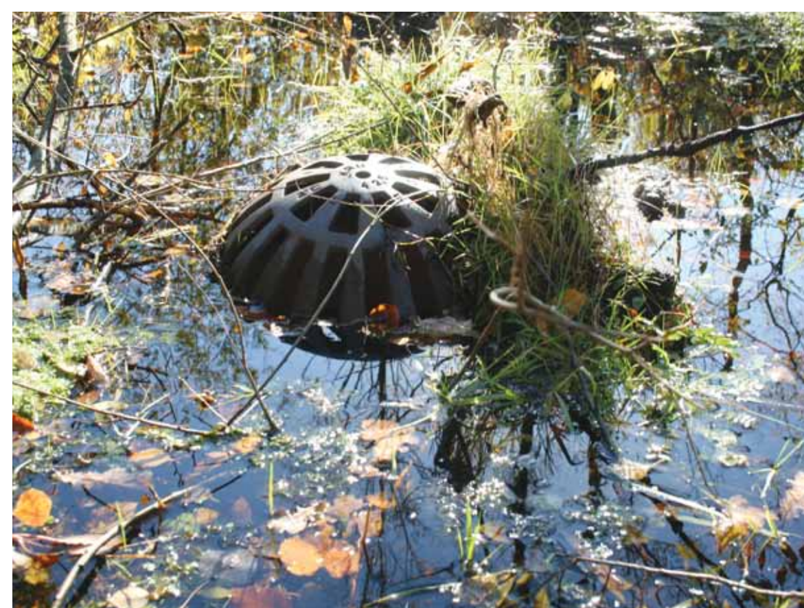
Vandstanden i mosen er hævet ved overløbsriste at hæve afløbstærsklen for gennemstrømmende vand. Tilløbende vand fra mosens sydside overrisler nu Glasværksengen for at rense det for næringsstoffer. Endelig er der nedsat mange små spurs inde på mosen for at bremse afløbet af regnvand fra moselåden. LIFE-projektet 2010 - 2013.
