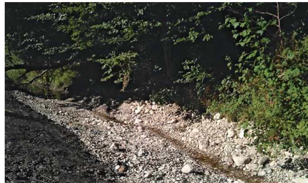
Allébet fra Holmegaard Mose mod nord gennem Tornemoserenden er blevet forhøjet med 35 cm ved udlæggelse af stenstryg. LIFE-projektet 2010 - 2013.
