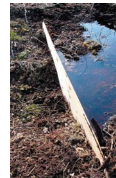
Vandstanden hæves ved hjælp af spunsere på tværs af de gamle afvandsgrafter.
