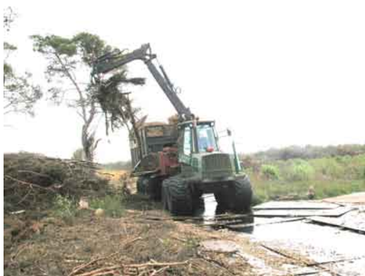
Figur 18. Flishugning på pladevej.
