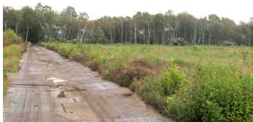
Figur 20. Pladevej til lastbiltransport.
