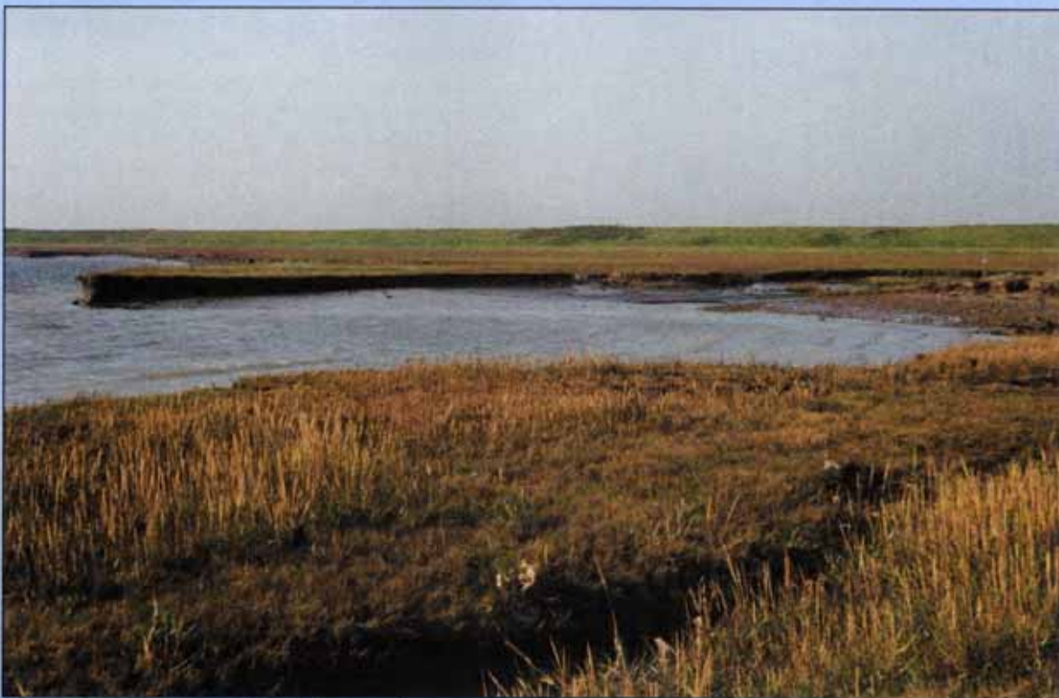
Figur 104.5. Foto taget ind mod det nye dige, der ligger tilbagetrasket i forhold til det gamle, gennembrudte dige øst for Juvre på den nordlige del af Rømø. Man kan her se den tydelige erosionskant i marsken. Foto: Merete Binderup (2003).
