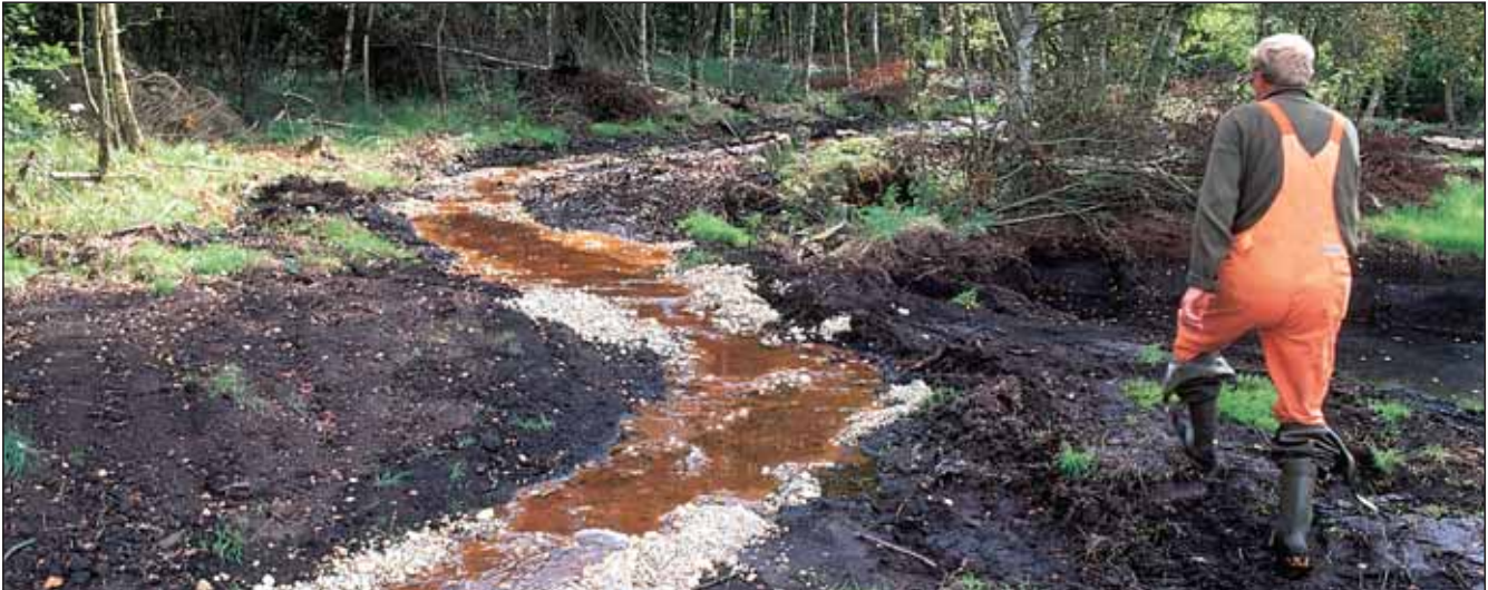
Das Anheben des Wasserstandes auf sein natürliches Niveau kann die Ockerverunreinigung stoppen. Hier wurde die Gewässersohle durch Einbringen von Kies angehoben.
