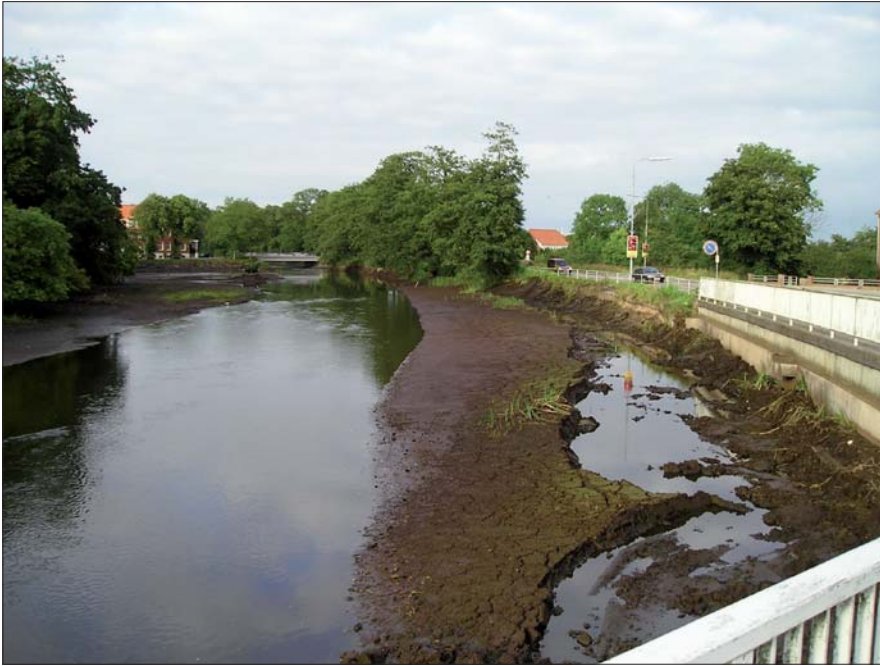
Figur 4. Kortvarig sænkning af vandstanden i møllesøen ved Bachmanns Mølle i forbindelse med vedligeholdelsesarbejder på Søndergade bro i slutningen af juli 2004. Kongevej ses til højre, mens Søndergade bro ses i baggrunden.
