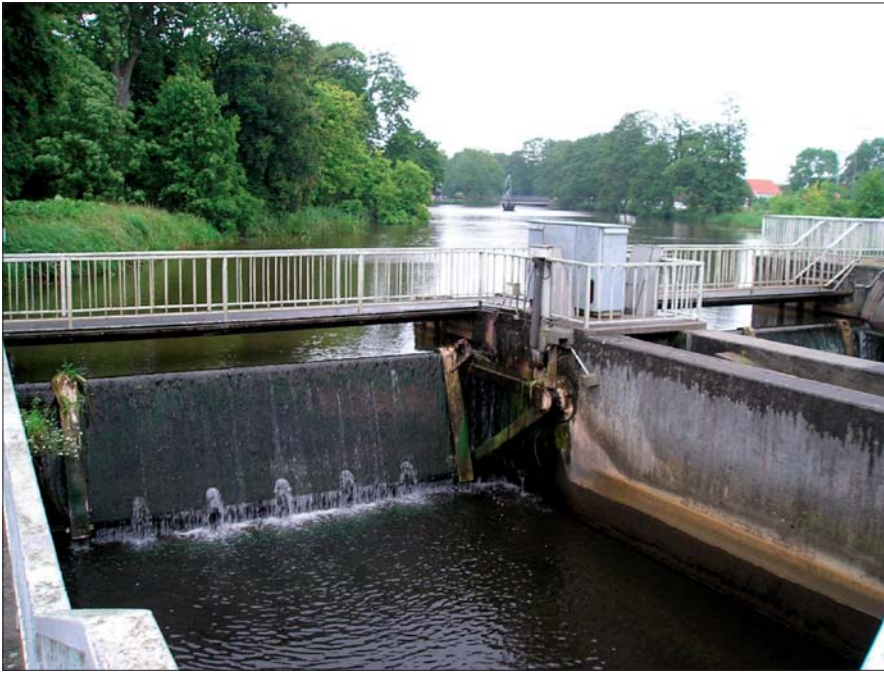
Figur 5. De automatiske stemmeporte ved stemmeværket ved Bachmanns Mølle. Fisketrappen er placeret mellem de to betonmure.
