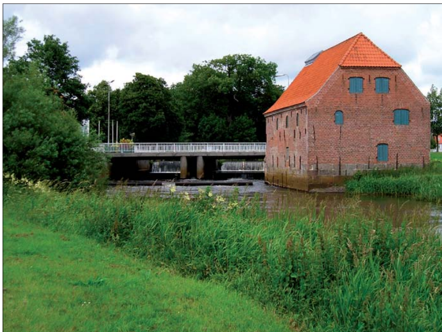
Figur 3. Bachmanns Mølle og stemmeværket med 2 automatiske stemmeporte og en fisketrappe i midten (modstrømstrappe).
