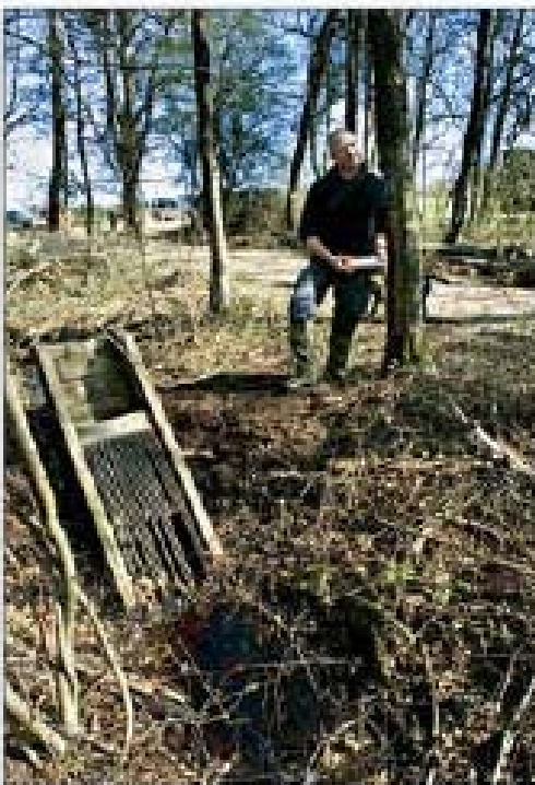
Skovfogeden viser de træmunkke, der skal sparre for vandet i kanalerne.
