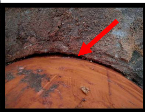
Billedet til venstre viser forbindelsen mellem to rentvandstanke. Detailbilledet til højre viser, at samlingen ikke er tæt og kan medføre indsvivning af overfladevand.
