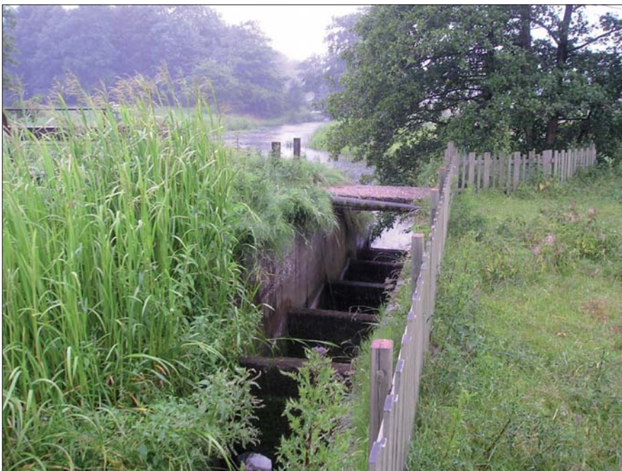
Figur 3. Fisketrappen ved stemmeværket for Rens Dambrug
