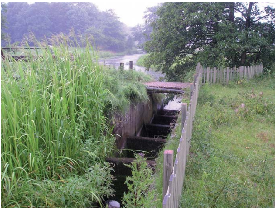
Figur 3. Fisketrappen ved stemmeværket for Rens Dambrug
