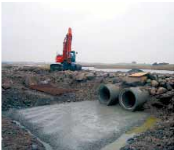
Anlægsarbejde i Tryggelev Nor Foto: Henrik Mørup-Petersen
