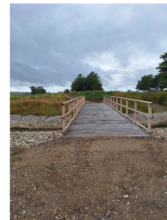
Bro til gående/cyklende over udløb
