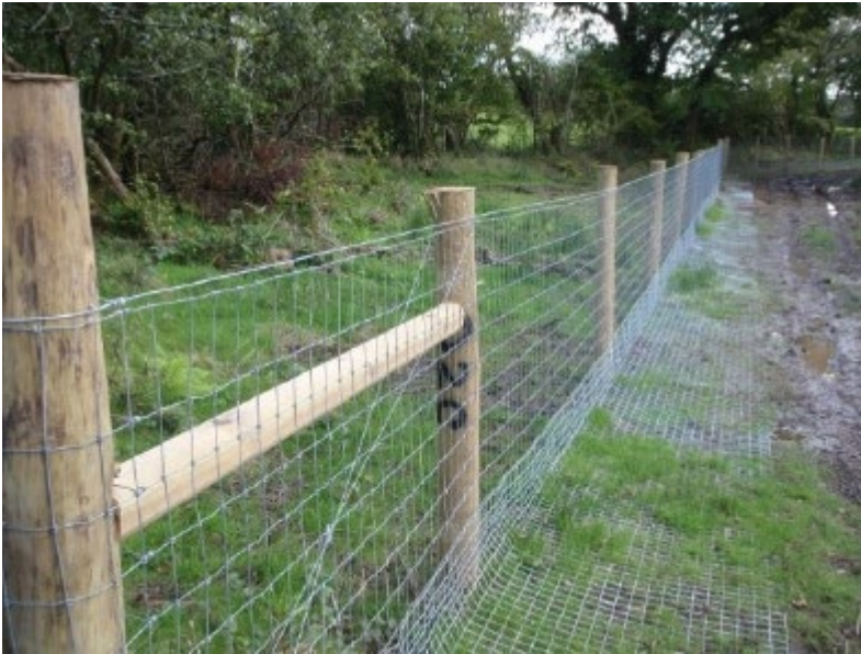
Trådhegn med ekstra trådnet, der hindrer bævere i at grave under hegnet. Foto: R. Campell-Palmer.
