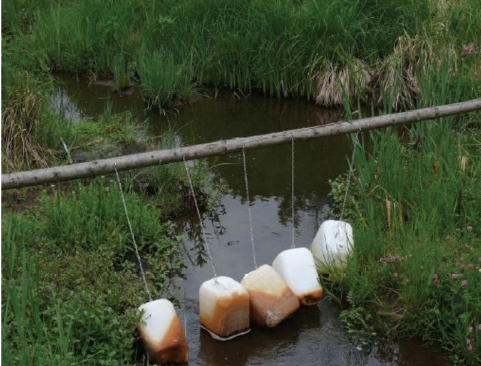
Plastbeholdere med grus ophængt på tværs af vandløb. Foto: G. Schwab.
