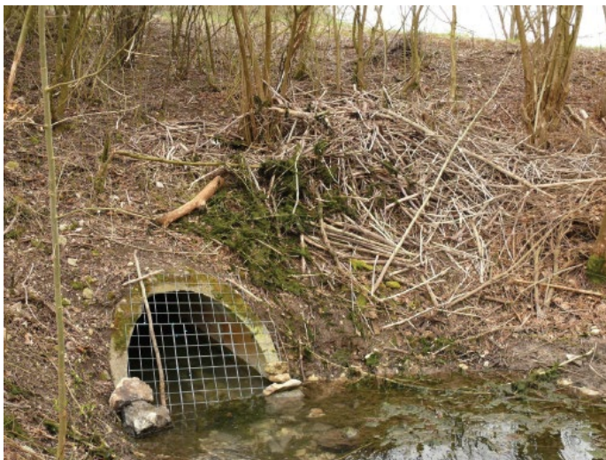
Trådnet foran rørunderføring. Bemærk bunken til højre for røret med materiale., der løbende er fjernet fra nettet. Foto: G. Schwab.
