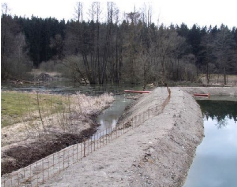
Rionet i nyetableret dige, der skal hindre bævere i at grave gennem diget. Foto: R. Campbell-Palmer.
