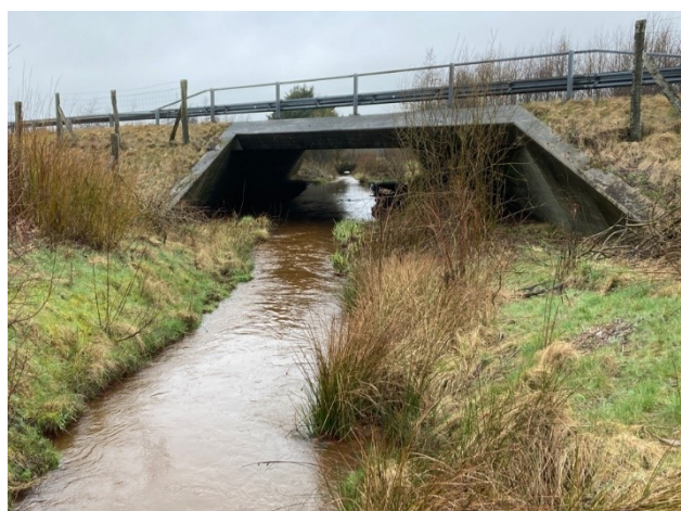
Afledningsgrøftens broindløb under motorvejen, hvor undersøgelsesområdet slutter
