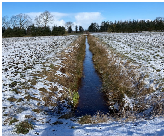
St. 1270 vandløbet er nedgravet og udrettet, og der er mangel på fysisk variation
