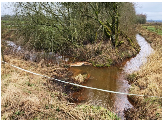
3St. 7880 Indløbet til okkerbassinet ved Teglgårdsvej
