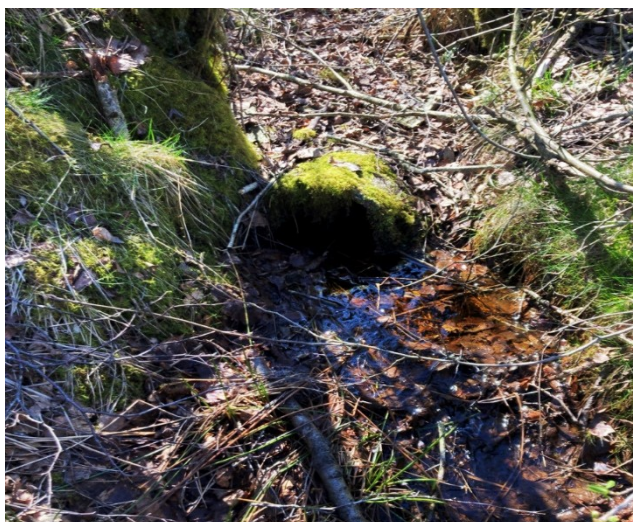
St. 3125 Ø25 ældre rørtiløb der kommer inde fra Troldmosen
