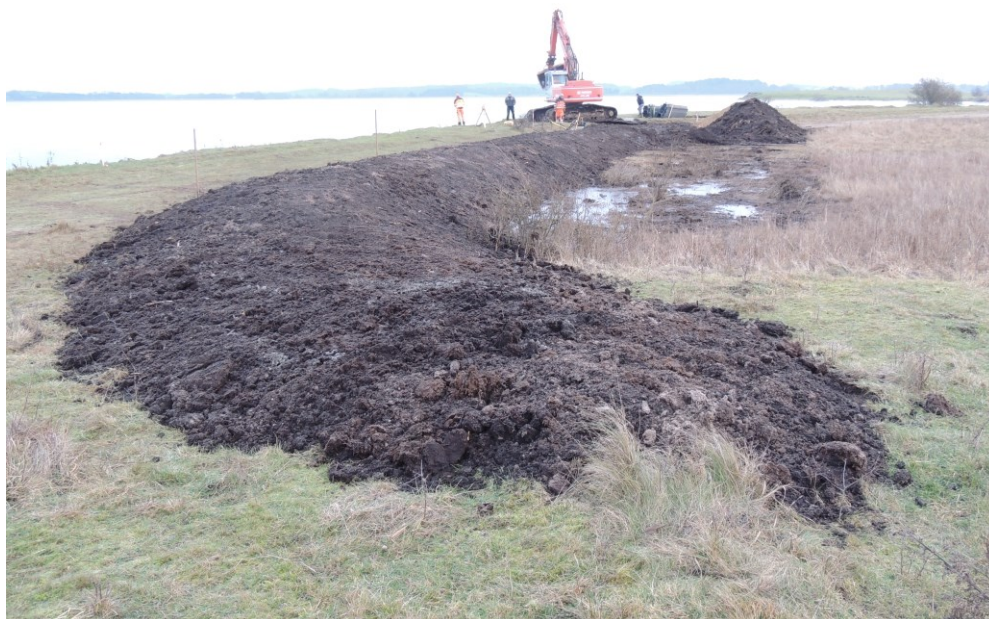
Billede 3. Etablering af dige i Ll. Lyngby Mose ud mod Arresø
