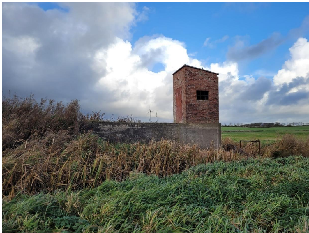
Figur 4.7: Pumpehuset ved afløbet fra Skadekær.
