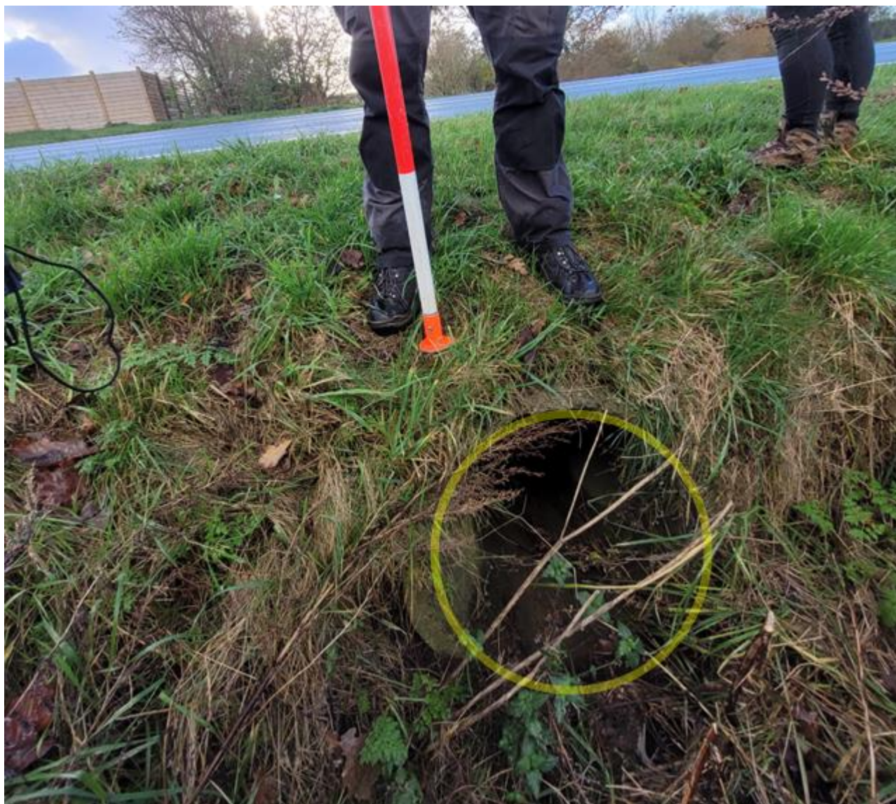
Figur 4.11 Rørlægning under Klitmøllervej.
