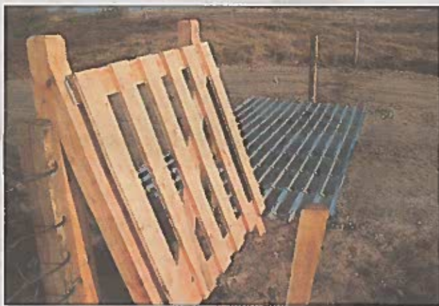
Ved Horneks er anlagt en passage af det store hegn med færst, låge og vognport for fx hestevognpassage.
