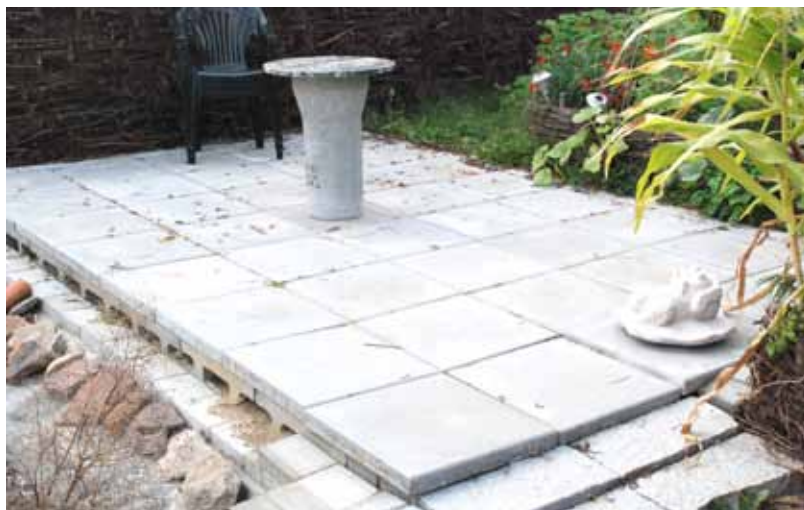
Foto 77. Haveterrasse anlagt sådan at tudser har let adgang til at krybe ind under terrassen.
