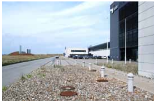
Foto 18. Arealer med befæstning og sten/ral ved klargøringscenteret for tog ved Øresundsforbindelsen på Amager.
