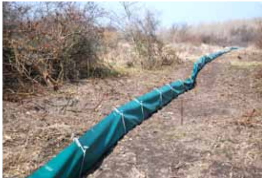
Foto 92. Midlertidigt paddehegn opsat for at holde grønbrogede tudser væk fra en kommende byggeplads. Gedser 2011.
