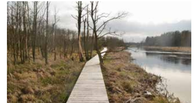
Træsti i hårdt træ ved Vejerslev Skov 130 cm bredde – hævet ca. 50 cm over terræn på pæle af robinie.
