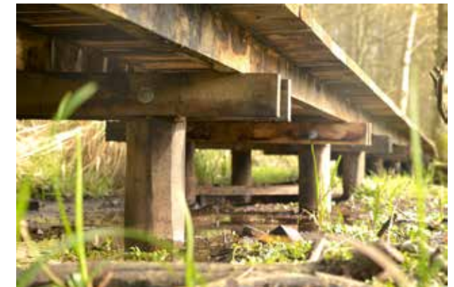
Træsti i hårdt træ ved Vejerslev Skov 130 cm bredde – hævet ca. 50 cm over terræn på pæle af robinie.
