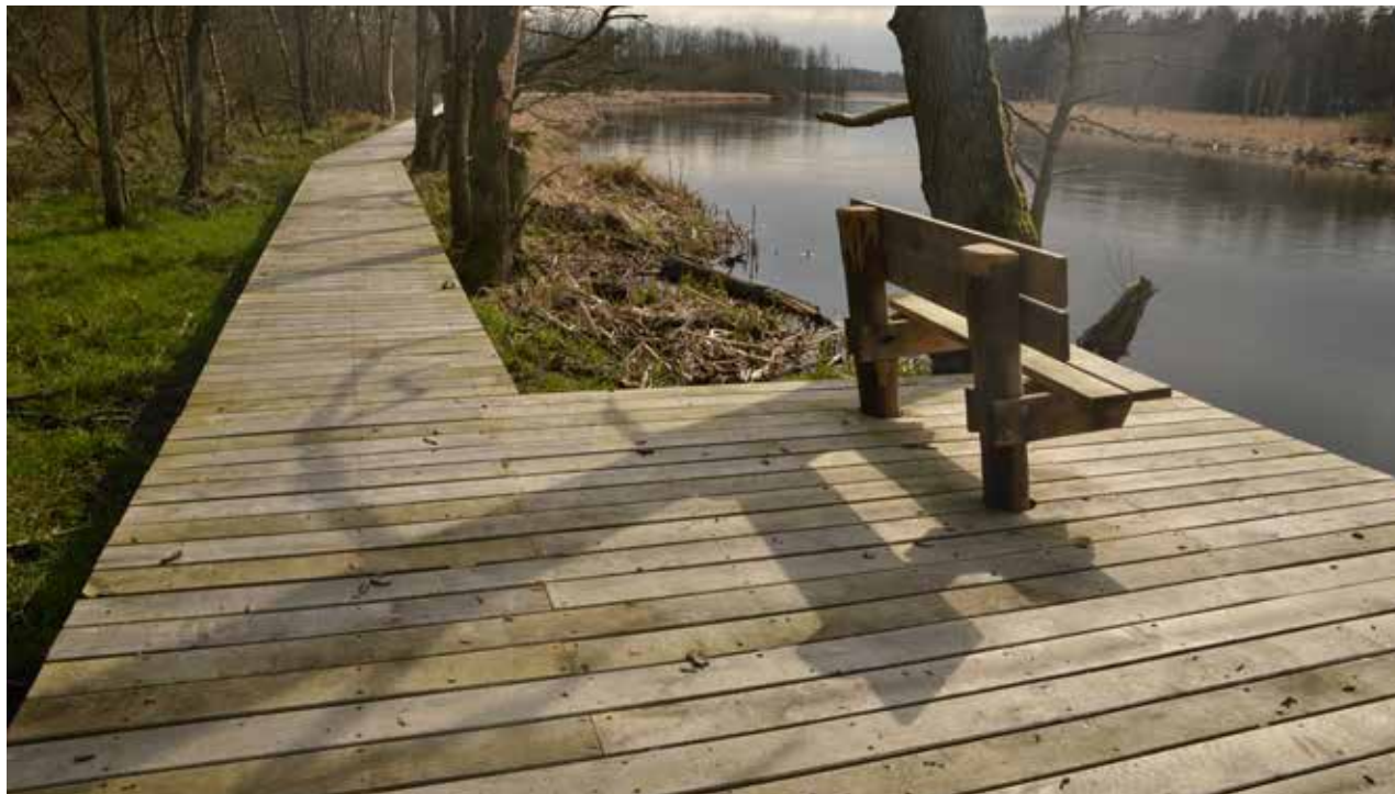
Træsti ved Vejerslev Skov 130 cm bredde – hævet ca. 50 cm over terræn på pæle af robinie og dæk i eg.
